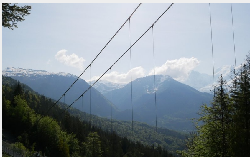
Passerelle du Nant Bordon (@julietteBuret)
