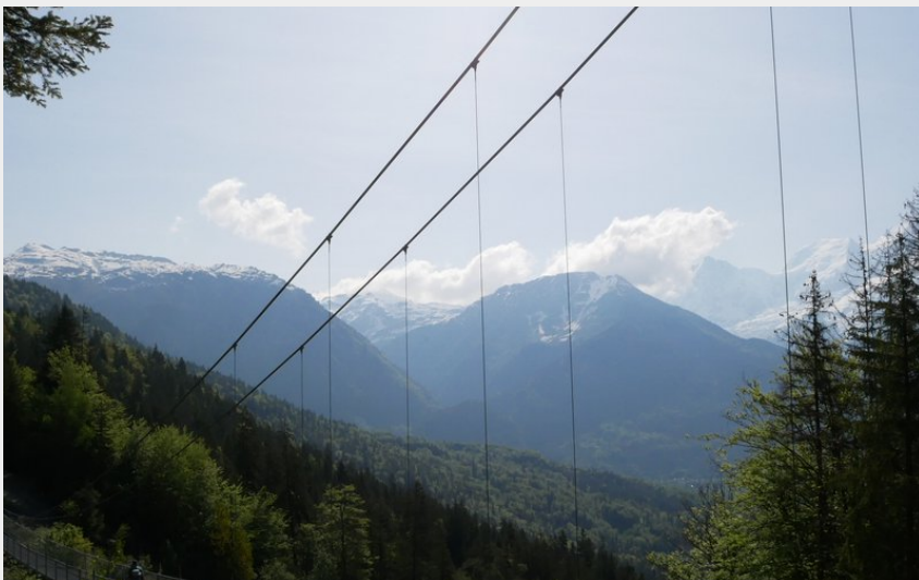
Passerelle du Nant Bordon (@julietteBuret)
