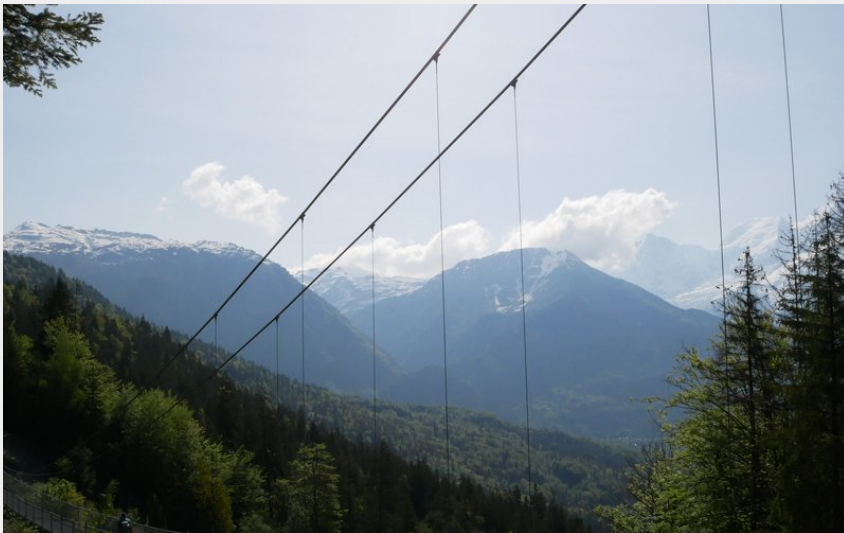
Passerelle du Nant Bordon (@julietteBuret)
